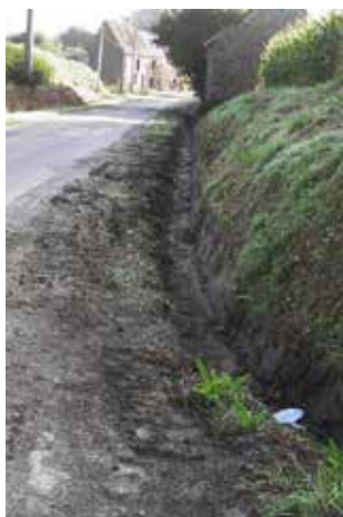
Réalisation des curages de fossés par l'entreprise Agriplus 3672€
